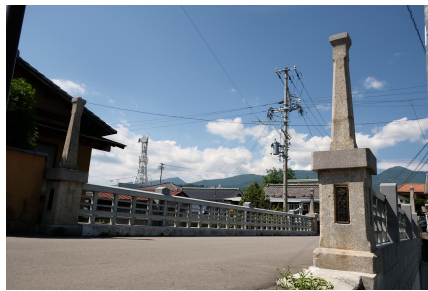
常盤橋・改修された時に、昔の橋柱を残し、デザインを踏襲した。
