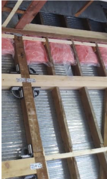
1階壁面・天井・床面取合部の断熱（気流止め）施工
