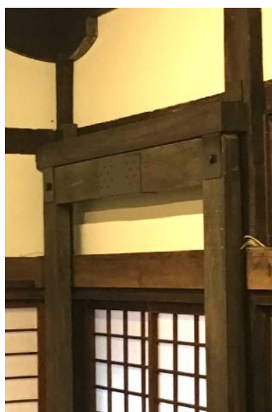
外陣のリブフレーム
