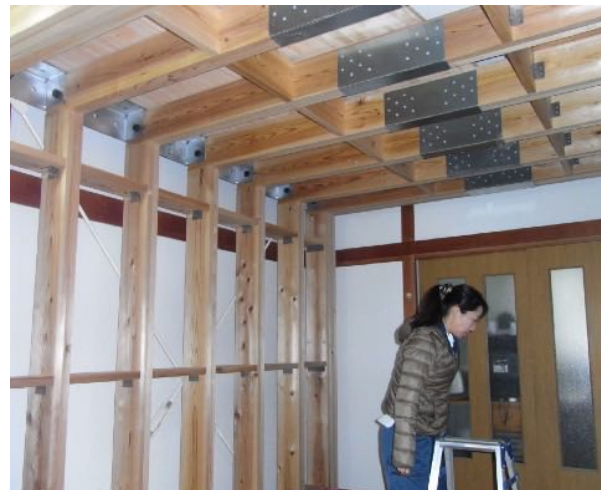
耐震シェルター組み立て作業直後の状況 (資材搬入から1-2週間)
