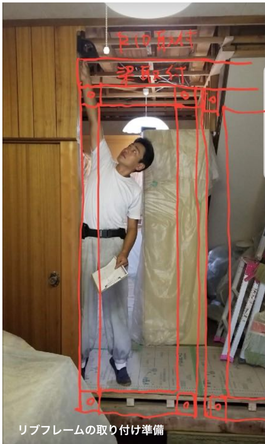
リブフレーム取り付け上部 (反力伝達のため横架材+束材)
