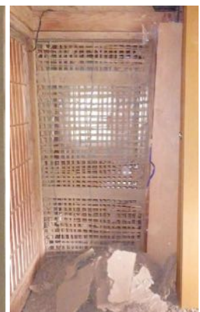
壁解体：葦の小舞
