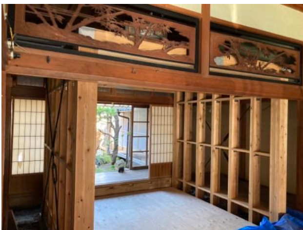
組み立て完了後の耐震シェルター
