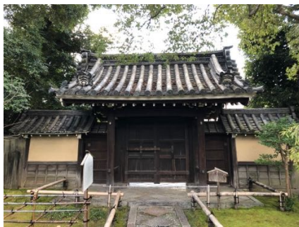
東側立面（庭園側）
