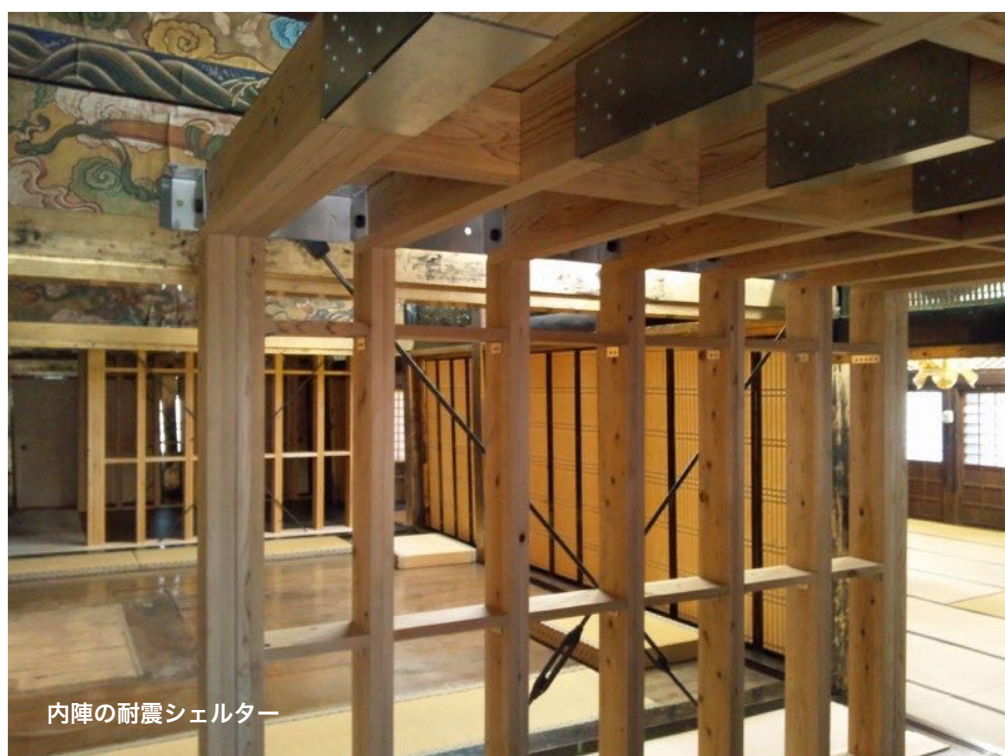
本堂内部に耐震シェルター設置後の状況
