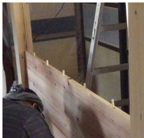
落とし込み板壁施工
