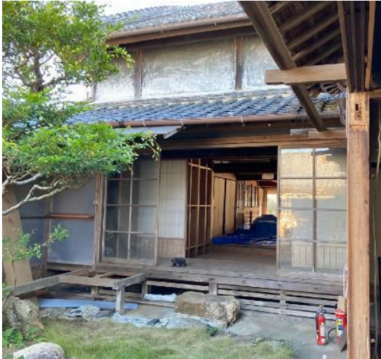
中庭から見た耐震シェルター
