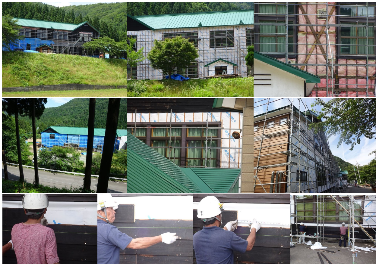
本棟外壁面・北側内部（2016年7月）外壁断熱施工と下見板貼り復旧
