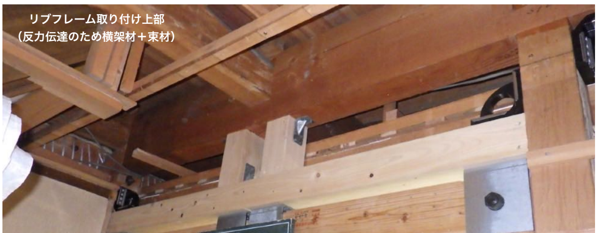
天井裏土壁充填 (横架材増設)
