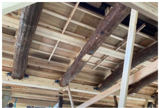
座敷棟小屋面の水平力伝達補強
