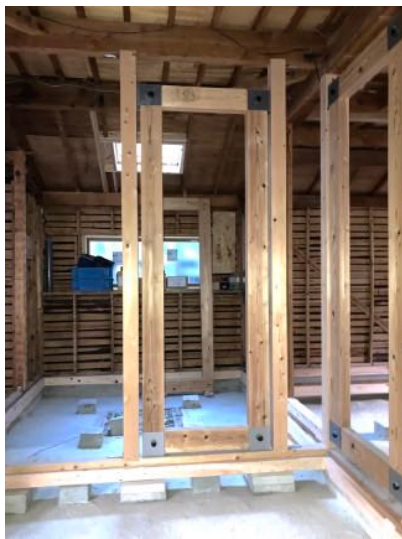
（耐震補強リブフレーム）14箇所
