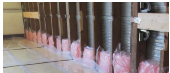
1階壁面・天井・床面取合部の断熱（気流止め）施工
