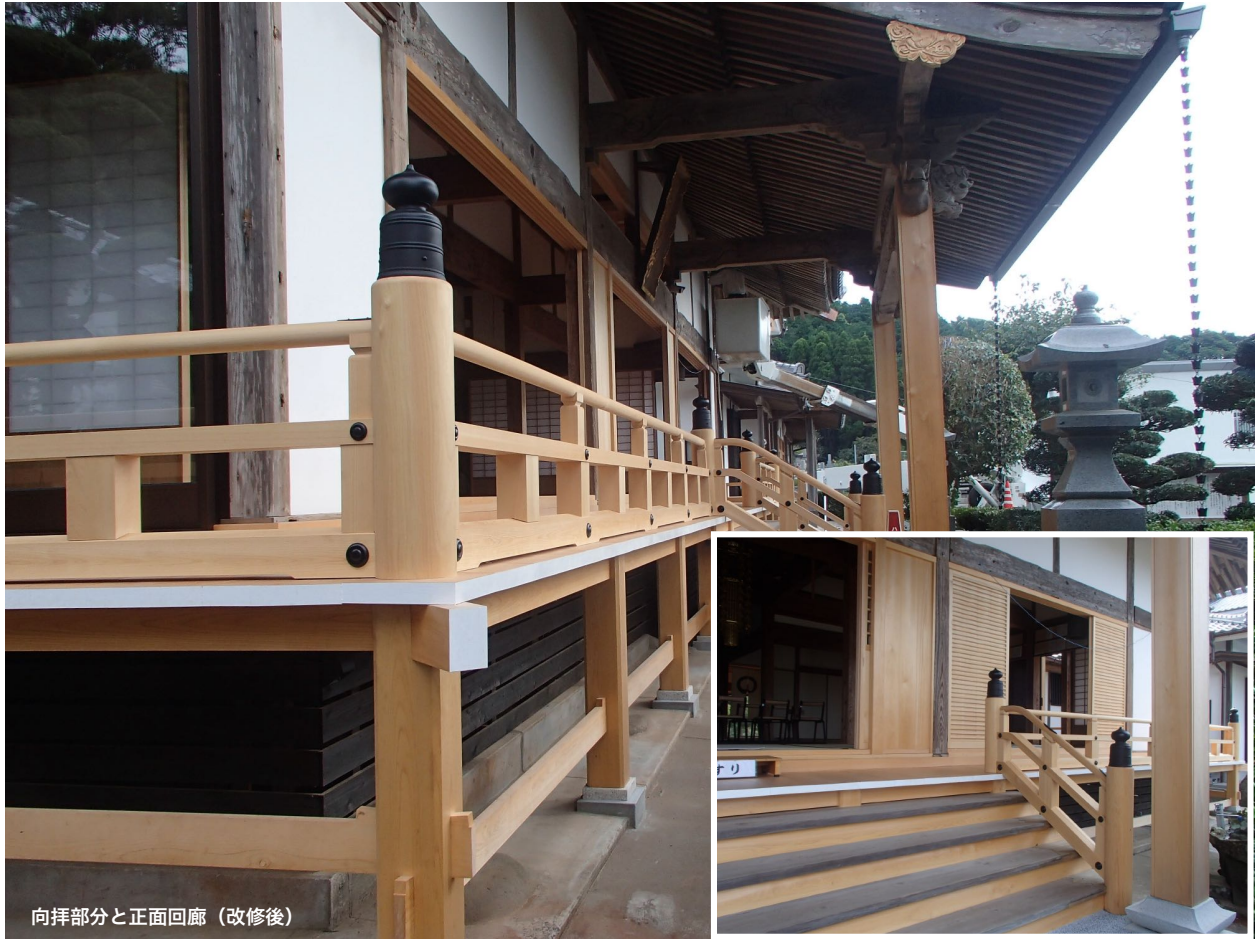
本堂西正面（2018年10月）竣工
