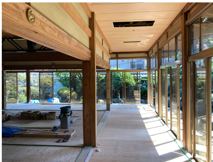
傾斜是正・補強工事完了（2021年）
