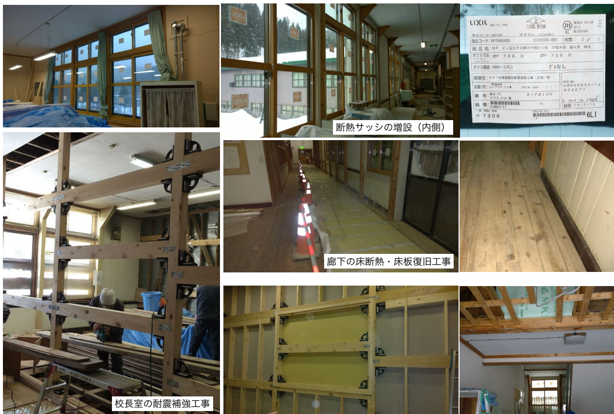
本棟（南側内部）耐震補強・断熱工事（2016年2月）
