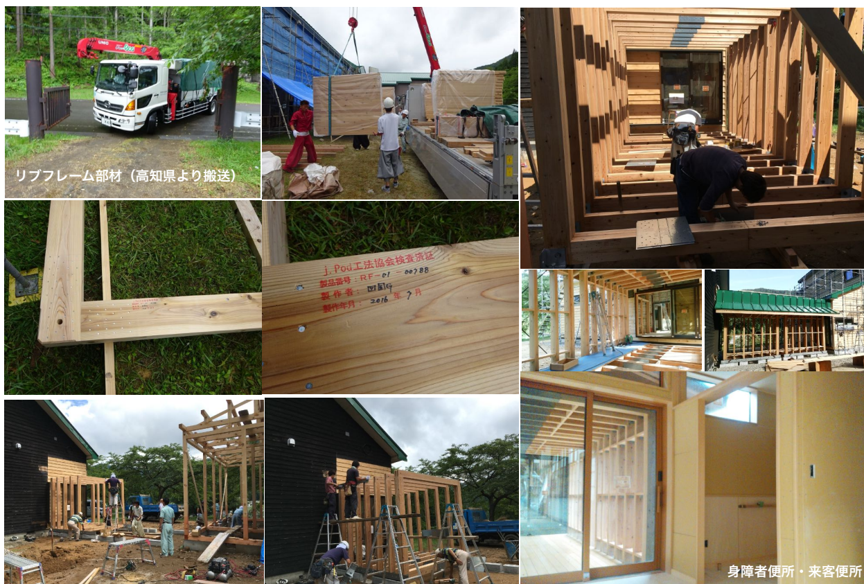
本棟外壁面・北側内部（2016年7-8月）渡り廊下（シェルター）資材搬入と組み立て
