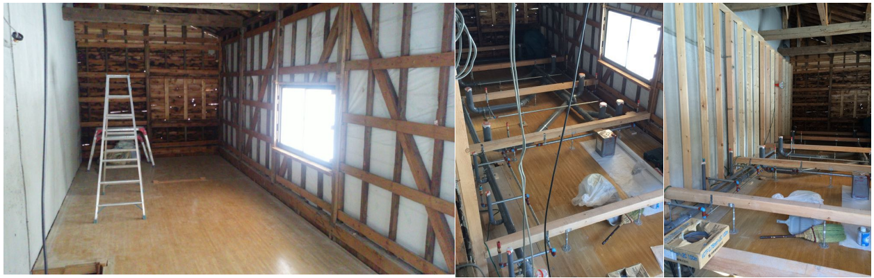
本棟（南側内部） 女子便所工事 (2016年1-3月)
