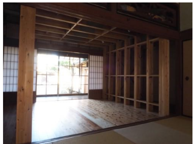
床フローリング仕上げ完了
