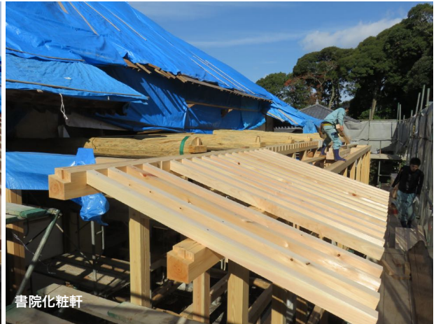
屋根改修工事
