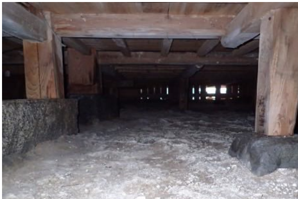
礎石・延石、部分的にコンクリート基礎（増築部）
