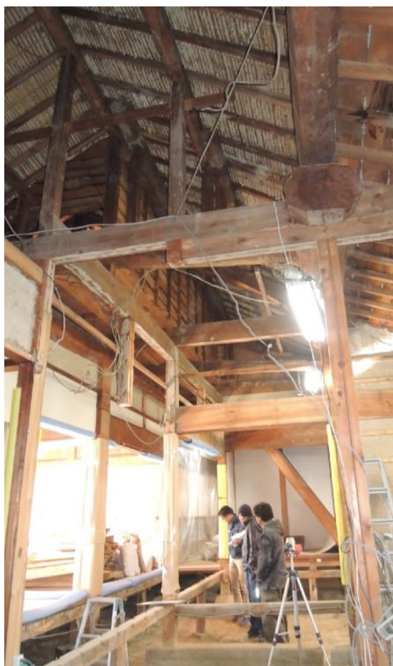
中廊下を挟む二つの軸組が小屋組を支える構造になっている - 天井を解体して調査する大工たち
